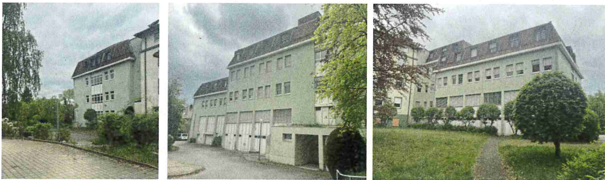
Abbildung 8: Bauteil 4 von Norden, Osten und Westen 21
