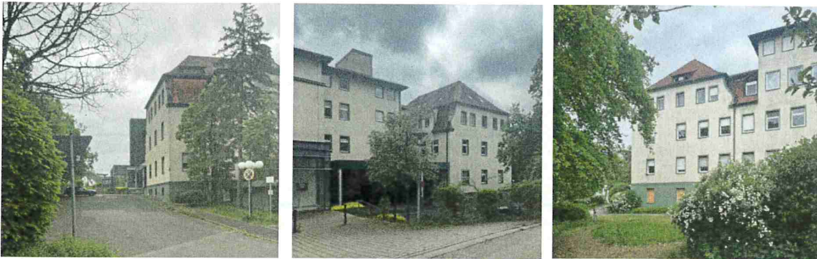
Abbildung 5: Bauteil 1 von Nordwesten, Nordosten und Süden 18
