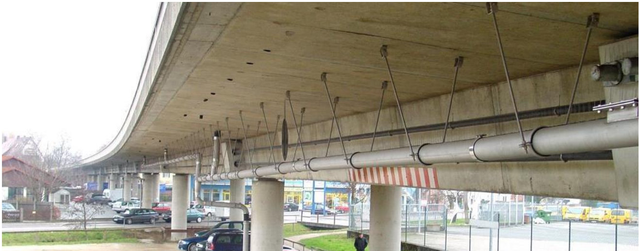
B 14, Unterführung Ostbahnstraße in Hersbruck
