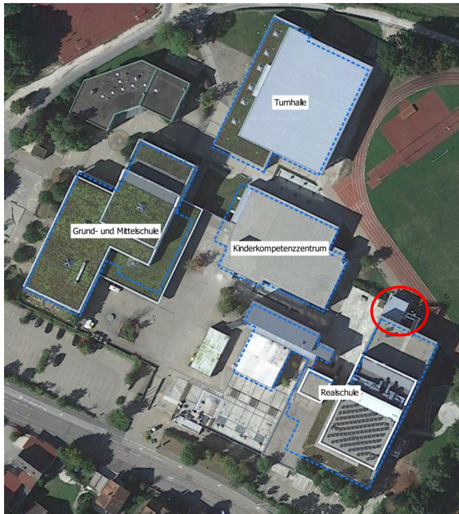
Abbildung 10: Luftbild der betrachteten Liegenschaften im Wärmeverbund Schulzentrum (eigene Bearbeitung, Datenquelle: Bayerische Vermessungsverwaltung, Google Maps)
