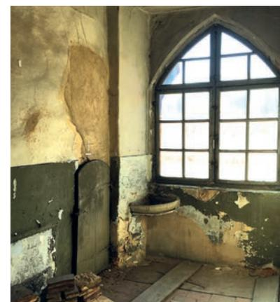
Feuchtschäden an den Innenwänden mit Rissen im Putz
